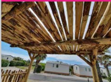
La toiture de la pergola est composé d'une structure en rondin et de 3 panneaux en rondins écorcés de différents diamètres.
