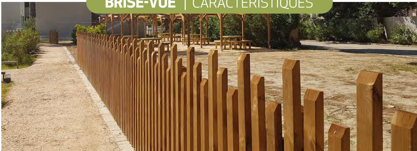
Réalisé avec des éléments de section 40 x 70 mm biseautés sur le haut et fixés en haut et en bas à l'aide de renforts de section 95 x 21 mm
